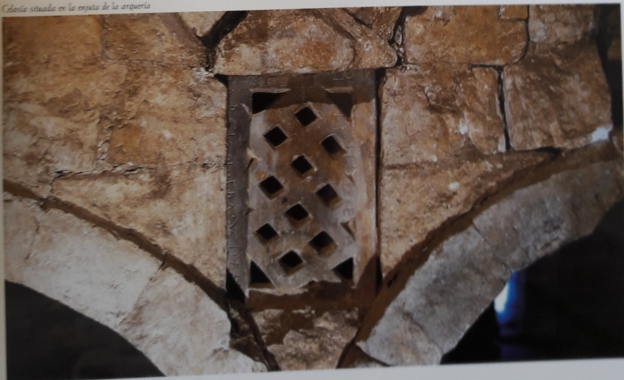
Celosía situada en la enjuta de la arquería
