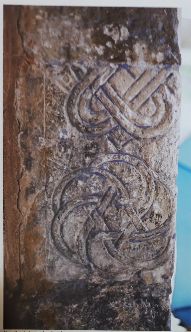
Detalles de la jamba derecha
