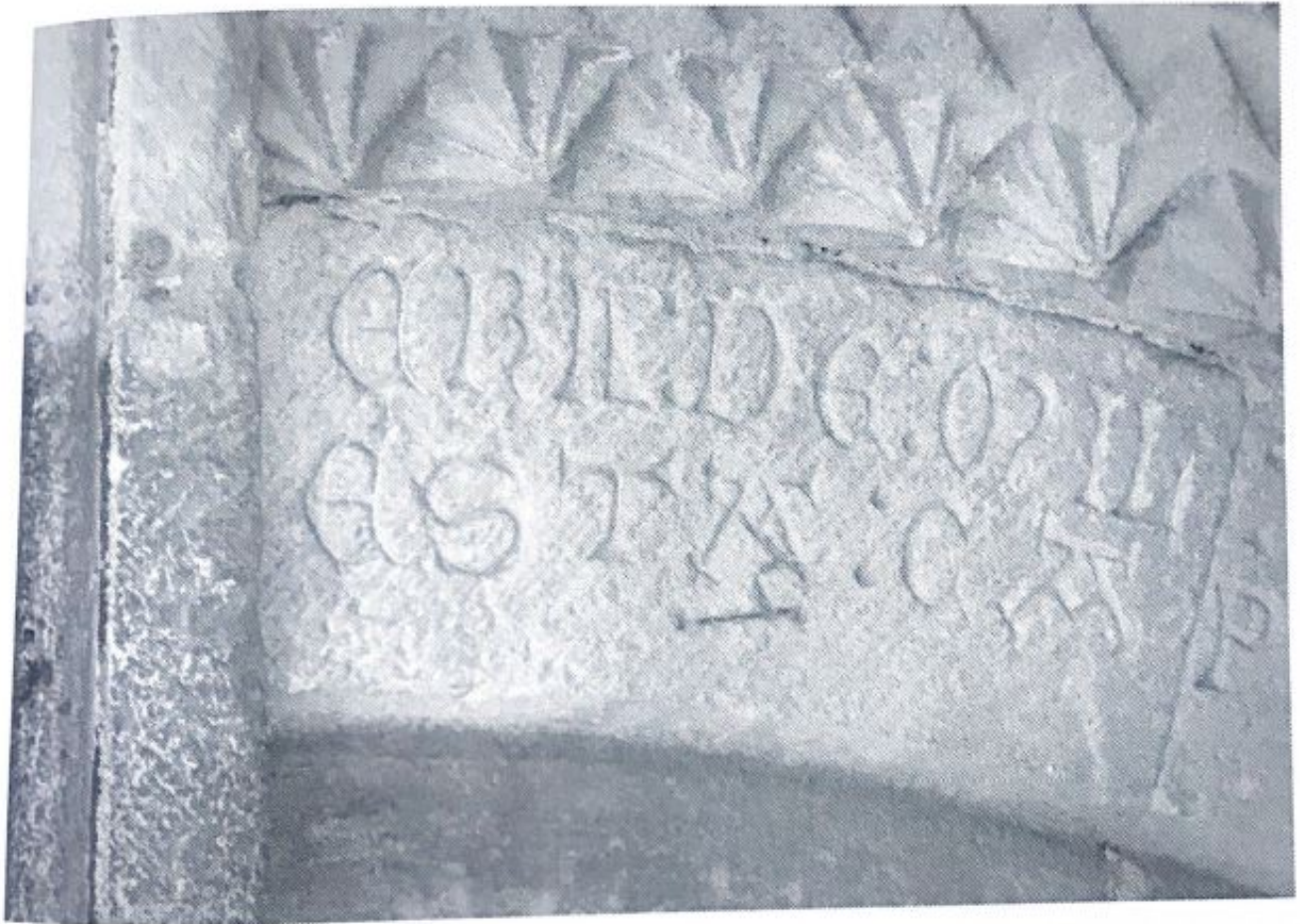
Fig. 121. Detalle de la primera dovela, donde pueden verse los dos tipos de A empleadas, así como la marca de cantero que se repite en la línea inferior de todas las dovelas.
