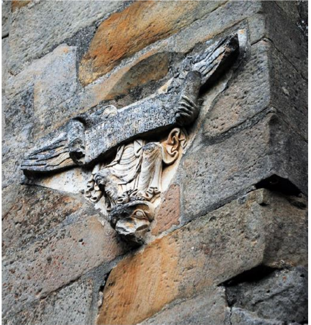
Fig. 1. Aguilar de Campoo, iglesia Santa María la Real, fachada occidental, ángel A (foto: autor)
