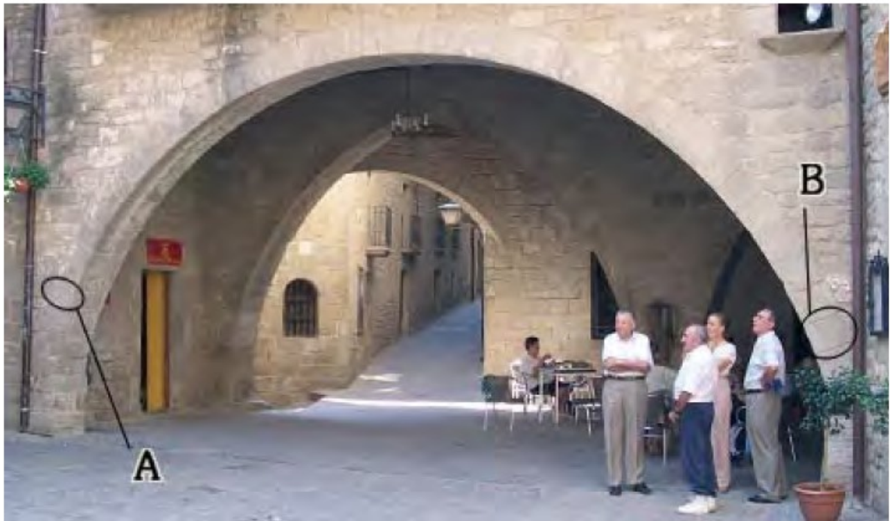
Fig. 1. Imagen general del soportal de Sos del Rey Católico.
